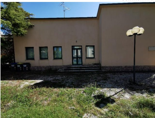
Ripresa fotografica del prospetto
