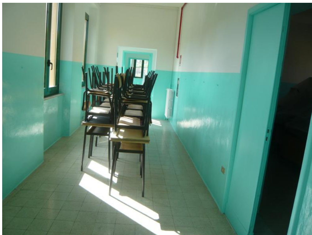
Foto 06 – Pavimento in graniglia piano secondo
