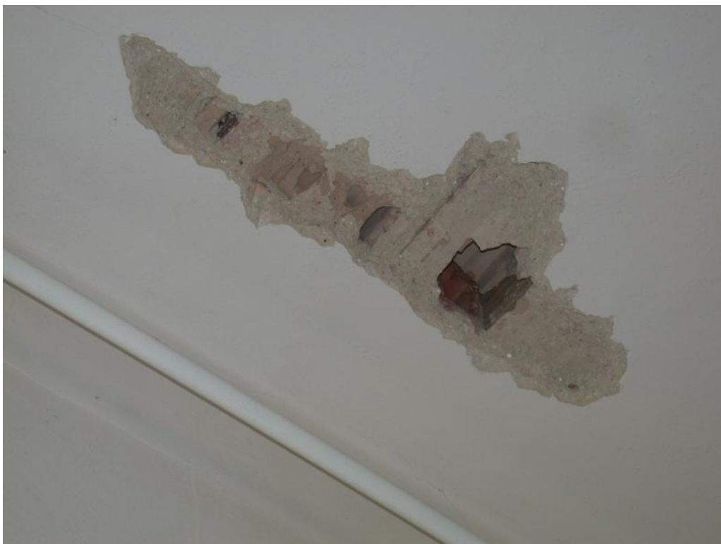
Foto 07 - Saggio intradosso solaio a SAP
