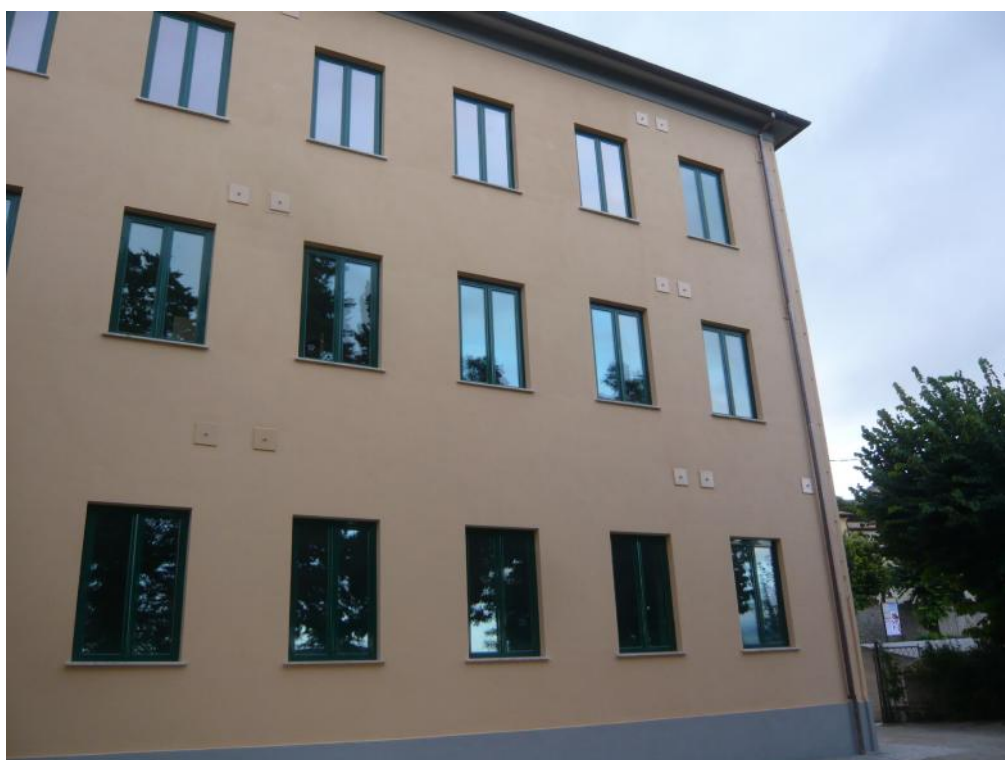
Foto 02 - Porzione prospetto Sud
