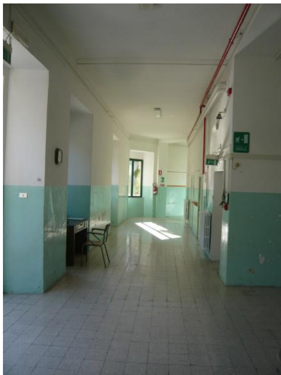
Foto 05 – Pavimento in graniglia piano terra
