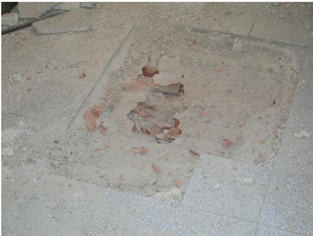
Foto 08 - Saggio estradosso solaio a SAP
